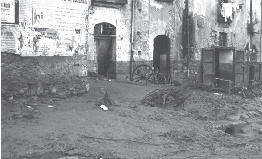
Fig. 15 – Cosenza, 24 novembre 1959 : effetti della piena del Crati in via Lungo Crati n.137 (S. 513e). Si noti il livello raggiunto dalle acque (traccia sul muro)
