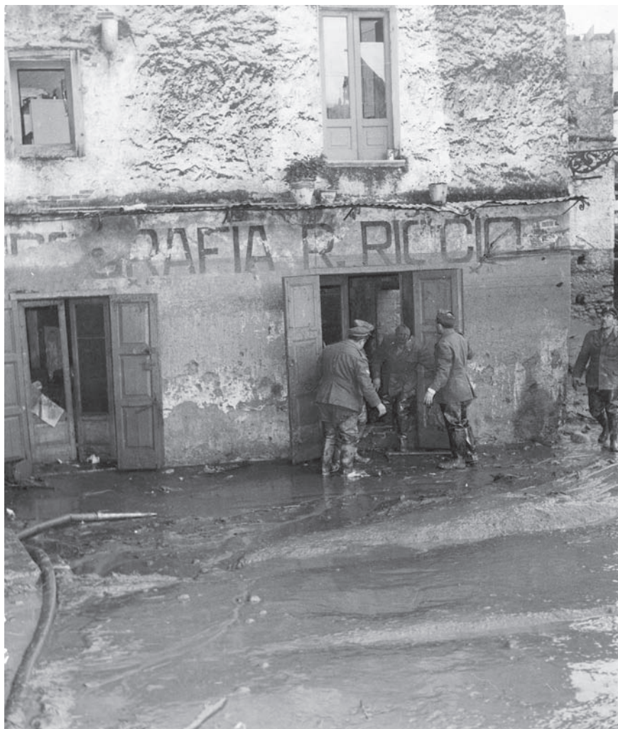
Fig. 18 – Cosenza, 23/24 novembre 1959: tipografia Riccio in via Lungo Crati. Sul muro è visibile la traccia lasciata dalle acque della piena (S. 513f)
