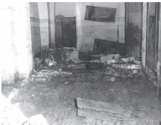
Fig. 14 – Cosenza, 24 novembre 1959: effetti della piena del Crati in via dei Martiri n.2. Sui muri è evidente il livello raggiunto dalle acque (S. 513e)
