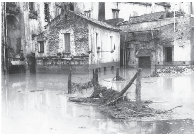
Fig. 17 – Cosenza, 24 novembre 1959: tipografia Riccio in via Lungo Crati (S. 513f). Si noti che il pianoterra è sommerso dalle acque
